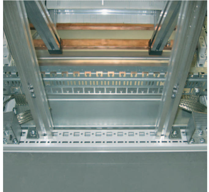
Einbausituation im TS8-Schrank (Fa. Rittal) - Befestigung des LSC-DISTANCE -Rahmens auf Montagewinkeln
