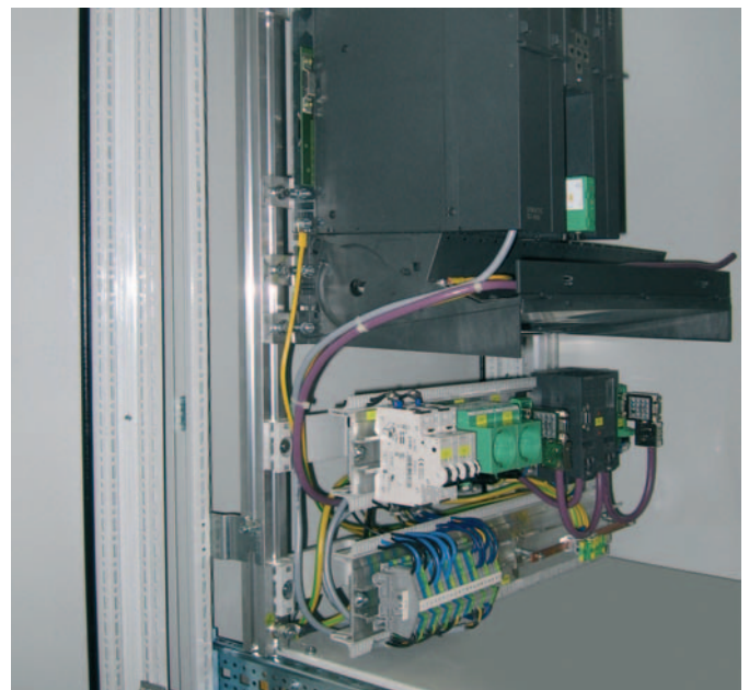
LSC-BRACKET-System im Programmierschrank
